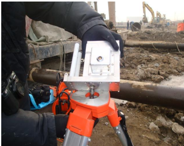
图 2 将提升装置安装到三脚架上
